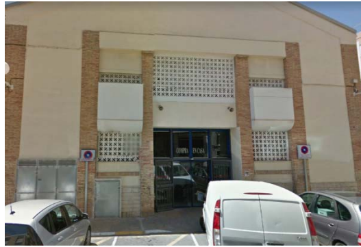
Imagen 3. Mercado de Abastos - Ventilación
