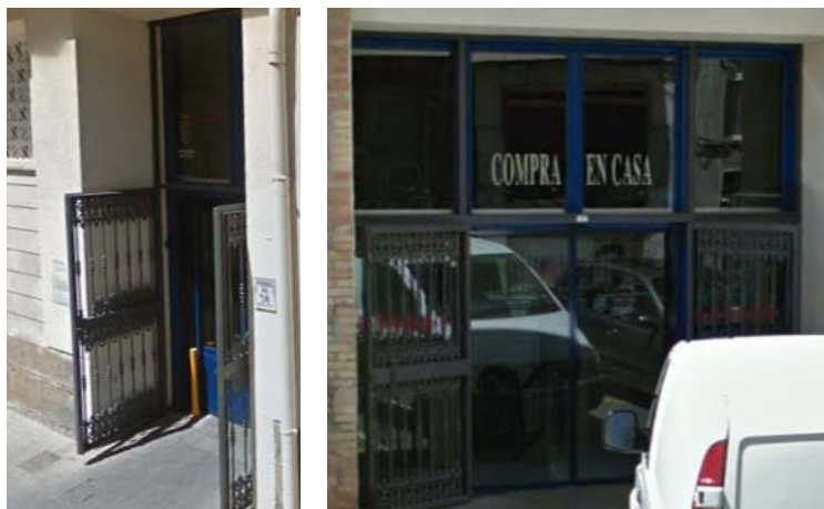
Imagen 2. Carpintería aluminio sin RPT+ vidrio monolítico - Dispositivo externo de control solar
